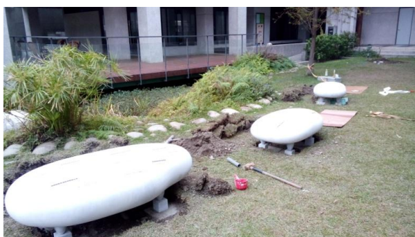
三處基座完成後大理石作品吊運固定安裝於基座上。
