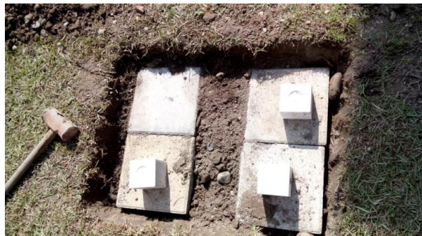
大理石作品安裝於草地前，開挖地表土埋設石板基座，避免作品下陷。
