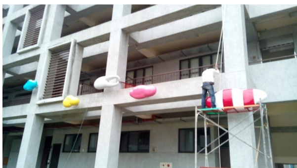
五件玻璃纖維作品安裝固定完成。
