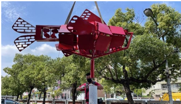
作品吊掛電源線設置
