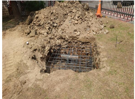
基礎鋼筋預埋
