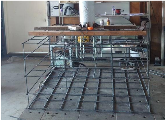
基礎綁筋結構
