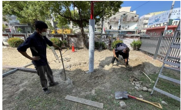
立柱安裝及表土回填
